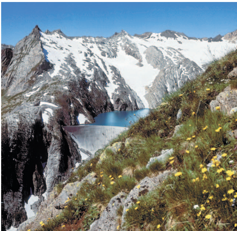
Bacino di Cavagnoli in Val Bavona: può accogliere l'acqua pompata dal bacino di Robiei, 370 metri più in basso, attraverso la centrale omonima (foto: archivio OFIMA).
