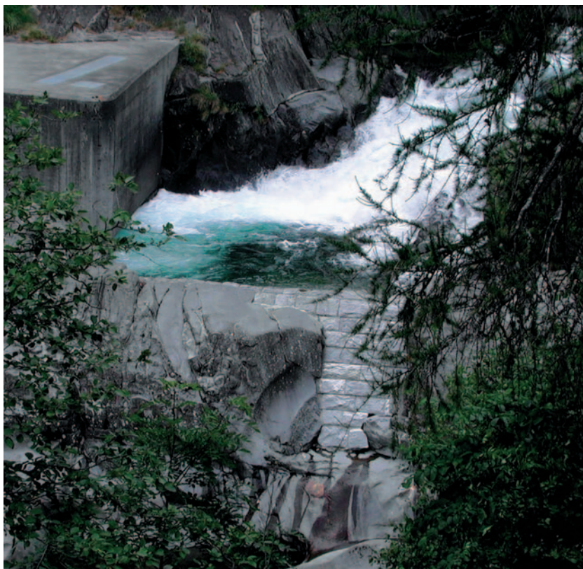
Presa d'acqua di Cambleo (Lavizzara): nel 1949 fu concessa senza vincoli, nel 1982 il Gran Consiglio decretò la restituzione di 100 litri d'acqua al secondo in estate e di 50 in inverno (foto Ufficio Caccia e Pesca / Tiziano Putelli)
