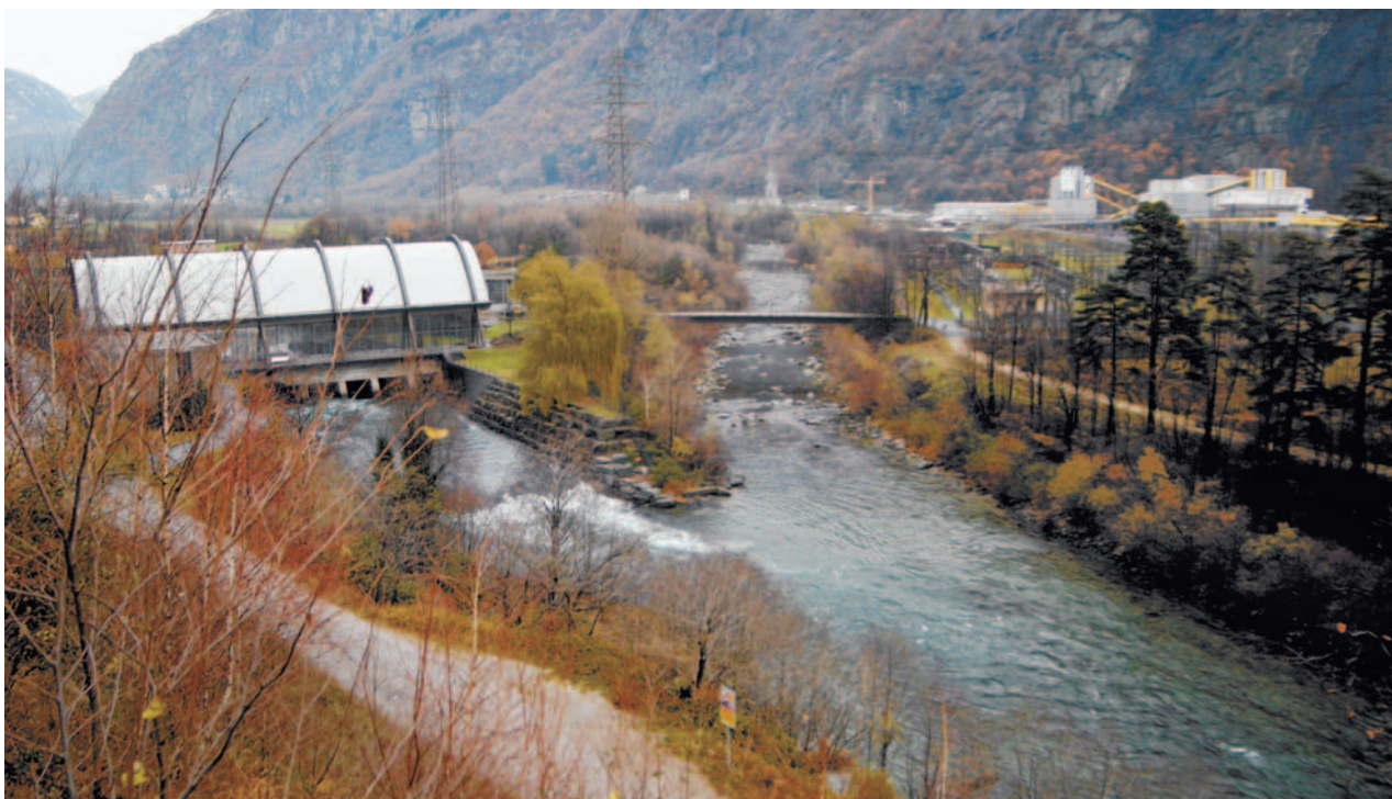
La centrale della Nuova Biaschina a Persico riversa fino a 54 metri cubi d'acqua al secondo (qui: una trentina) nel fiume Ticino che ha una portata ridotta (qui: solo un paio di metri cubi al secondo) (foto: Pro Natura Ticino / Alberto Spinelli).
